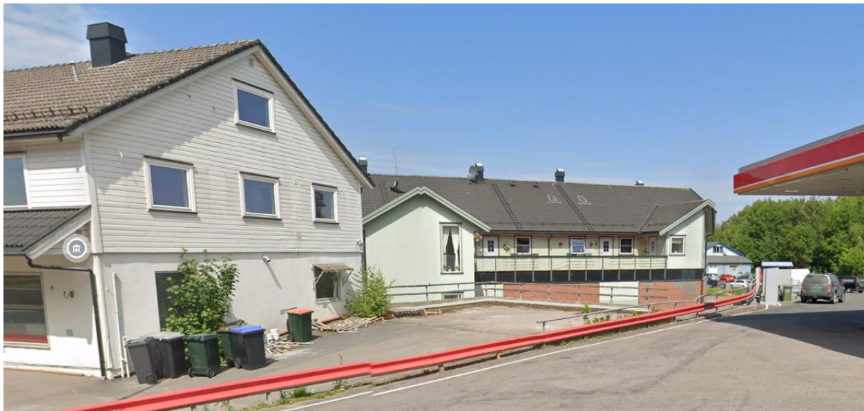
Figur 15 viser noen renovasjonsformer innenfor planområdet. Bilde tatt fra Google Maps
