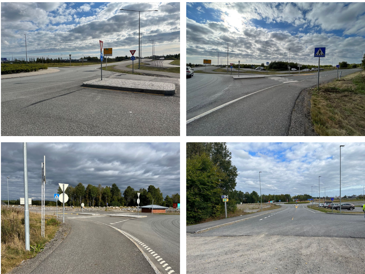
Figur 5-7: Nytt veianlegg. Bilder tatt av Multiconsult på befaring, 09.09.22.
