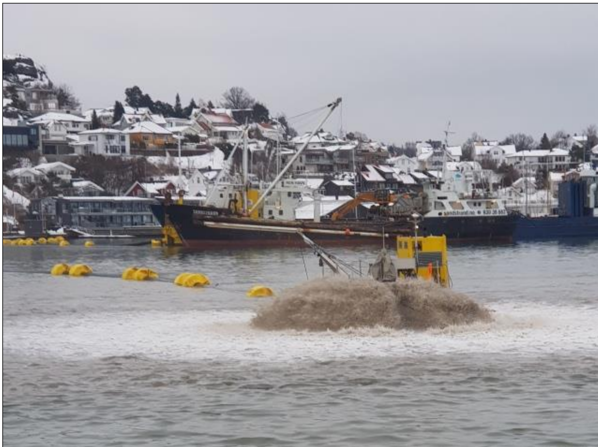
Figur 16. Drone under utlegging av tildekkingsmasser. Ren Havn ligger bak lastebåten. Massen blir losset direkte fra lastebåt til trakt på Ren Havn (foto: Bjørn Nygård)
