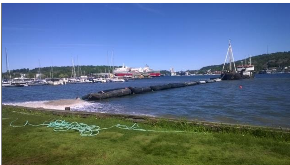
Figur 11. Tildekking ved testfelt 5, skipet Arena med påmontert slange (foto: Bjørn Nygård)
