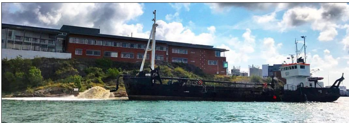
Figur 14. Utlegging av tildekkingsmasser med skipet Arena (foto: Skanska)
