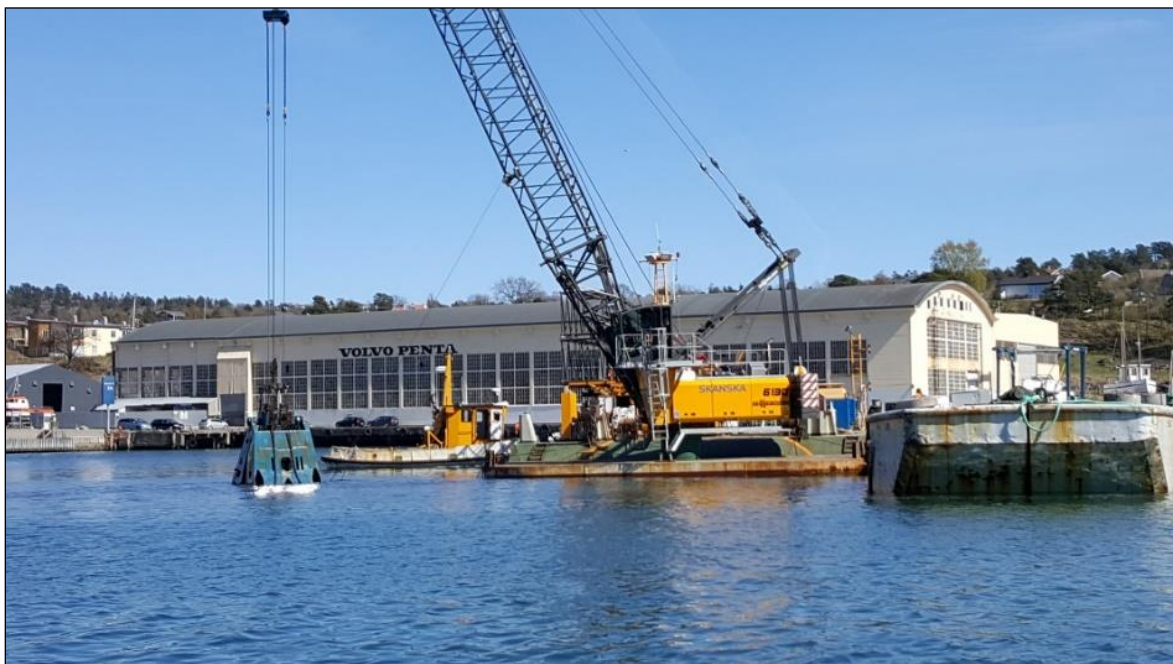
Figur 6. Grabb for nedføring av mudrede masser til deponi (foto: Sandefjord kommune)
