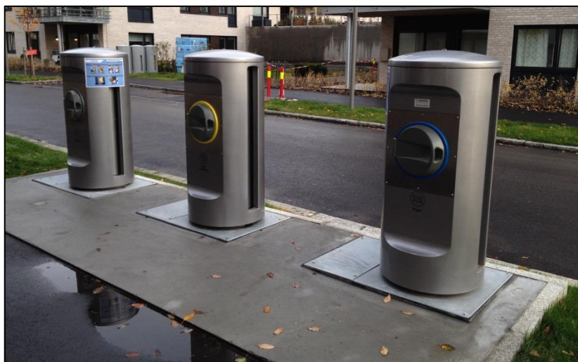
Figur 3-7: Nedkast til stasjonært avfallssug – 3 avfallstyper
